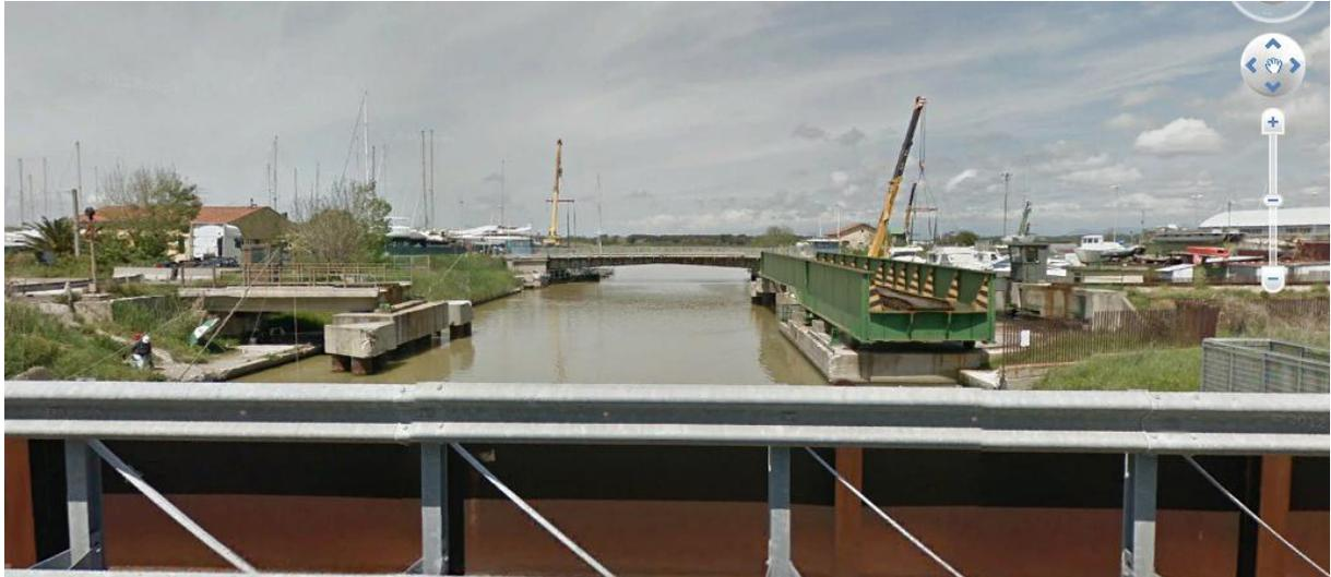
*Scavalco ferroviario Canale Navicelli – Ponte girevole con canale “chiuso”*
